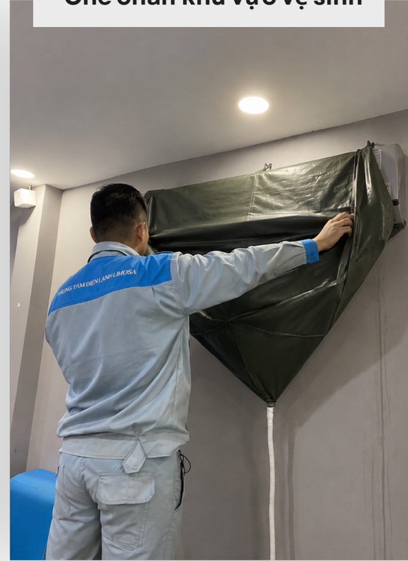
Che chắn khu vực vệ sinh
